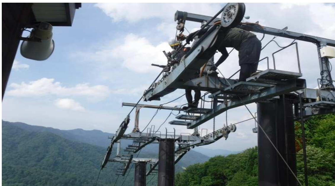
索受修繕工事
