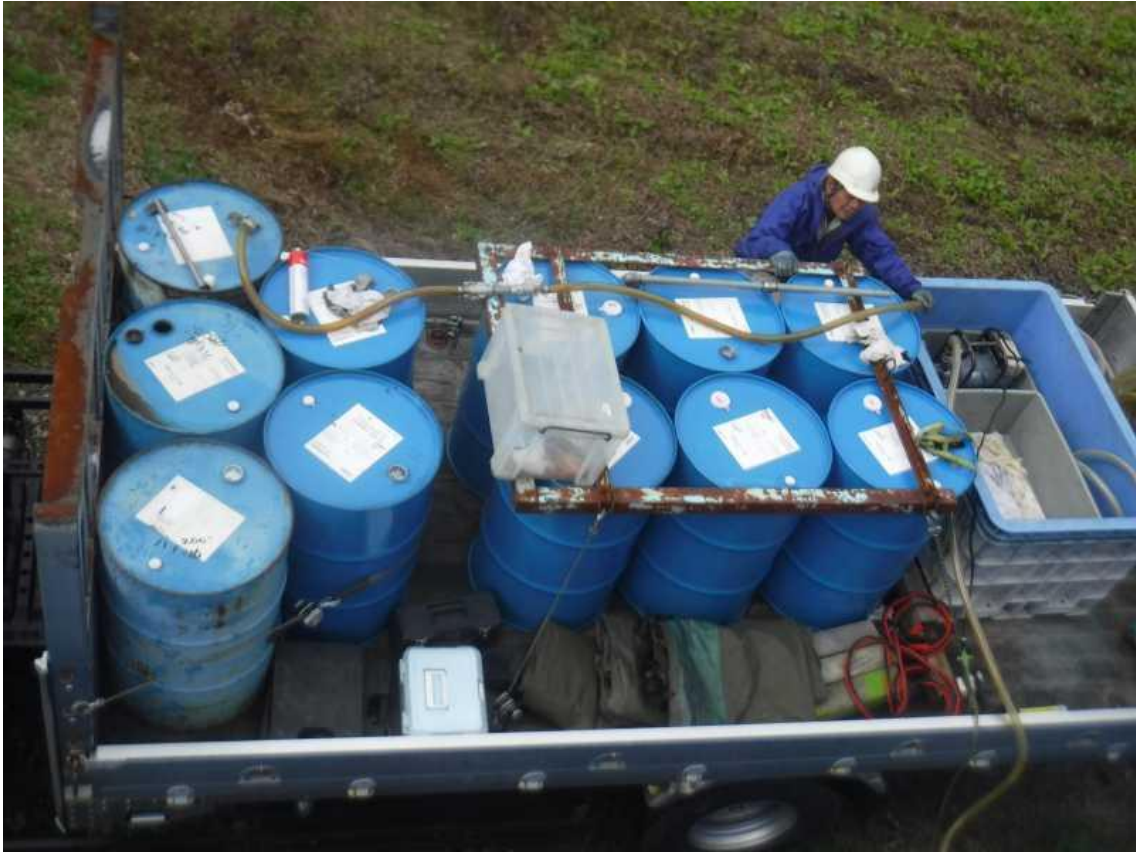
オイル交換工事
