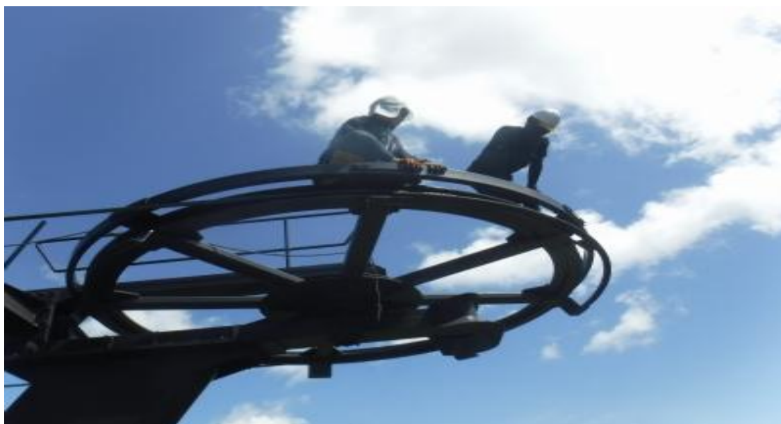
終端滑車修繕工事
