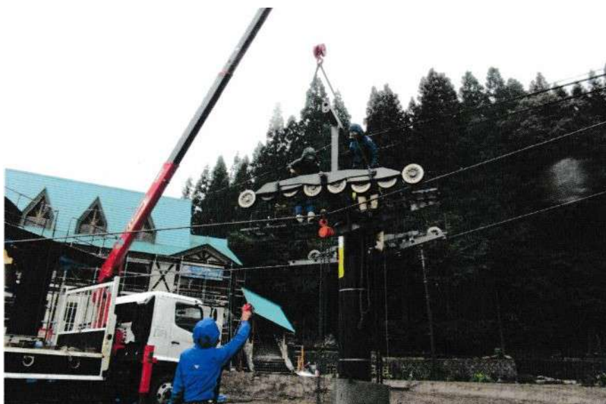
索受修繕工事
