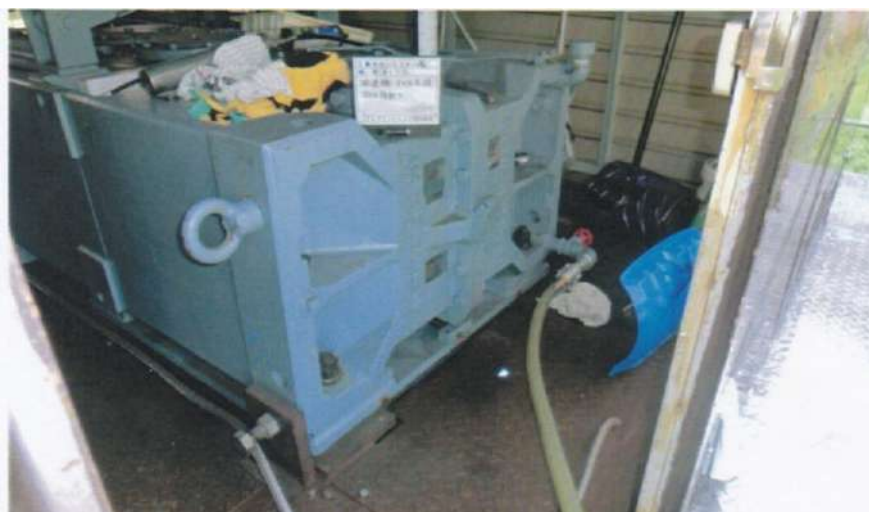
オイル交換工事
