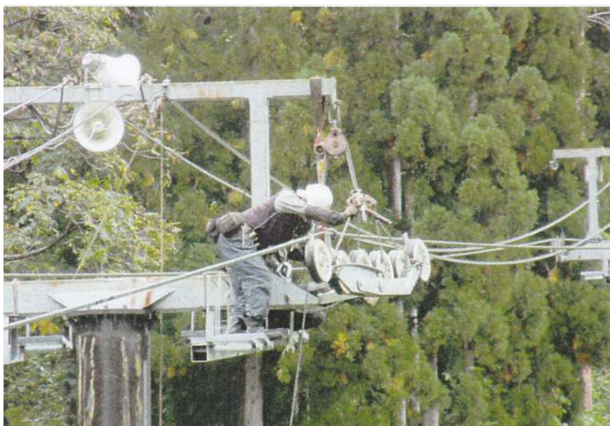
索受修繕工事
